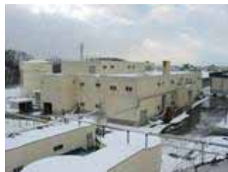
江別市水道部バイオマス発電所 250kW
