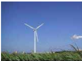
銚子屏風ヶ浦風力発電所 1,500kW
